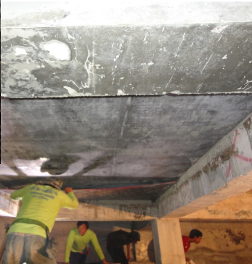
ถอดแบบและเก็บรายละเอียดพื้นชั้นล่างใต้อาคารที่ซ่อมทำใหม่
