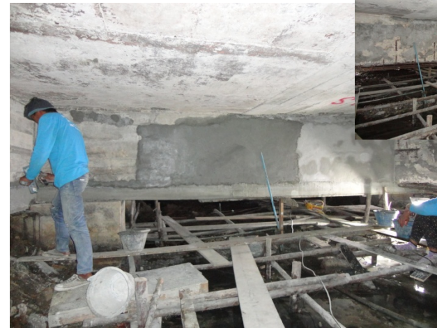
ฉาบแต่ง / เก็บรายละเอียดคานชั้นล่างใต้อาคารที่ซ่อมทำใหม่
