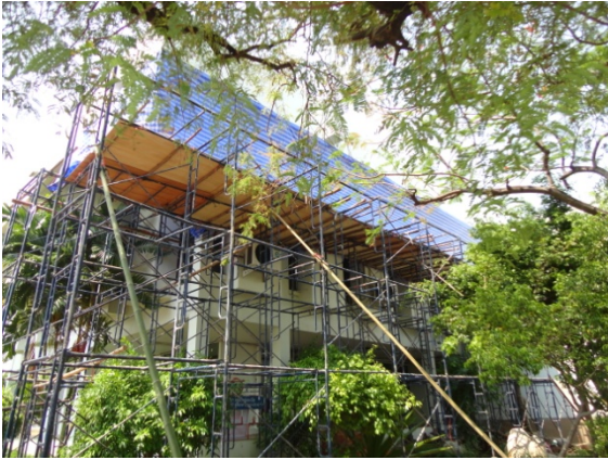
ติดตั้งนั่งร้านเพื่อดำเนินการซ่อมทำพื้นชั้นหลังคา
