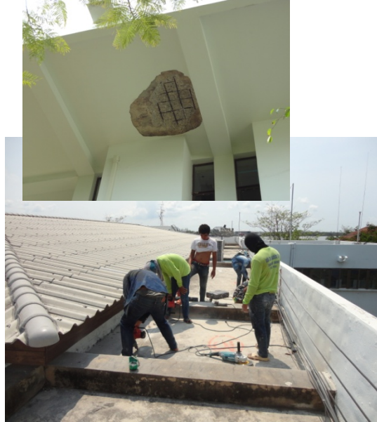
ดำเนินการสกัดพื้นชั้นหลังคาที่เสียหายมากเพื่อซ่อมทำใหม่
