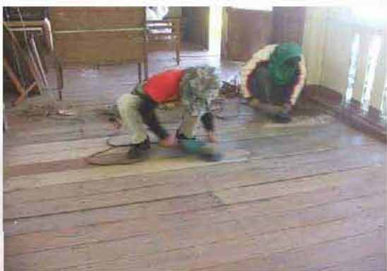
งานขัดพื้นไม้
