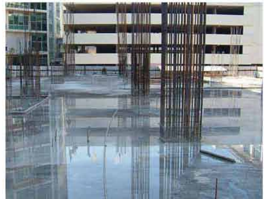
บ่มพื้นคอนกรีตด้วยน้ำ
