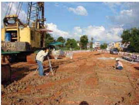
สำรวจกำหนดตำแหน่งเสาเข็ม
