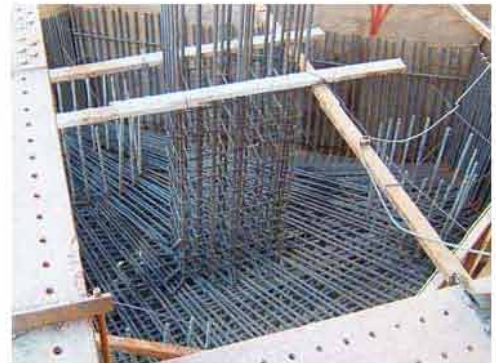
ลงเหล็กเสาและยึดให้มั่นคงแข็งแรง
