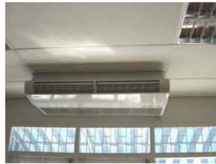
เครื่องปรับอากาศ Ceiling Type
