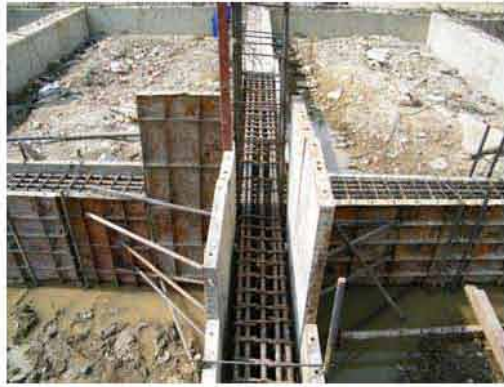
เตรียมเทคอนกรีต
