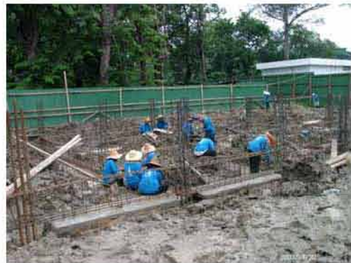
ผูกเหล็กเสริมคาน
