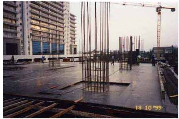
ติดตั้งแบบหล่อพื้น คอ.ร.
