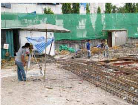
กำหนดตำแหน่งเสาเข็ม
