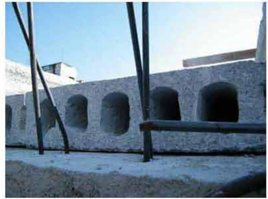
บริเวณคานรองรับ
