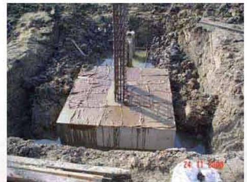
ปั๊มคอนกรีต
