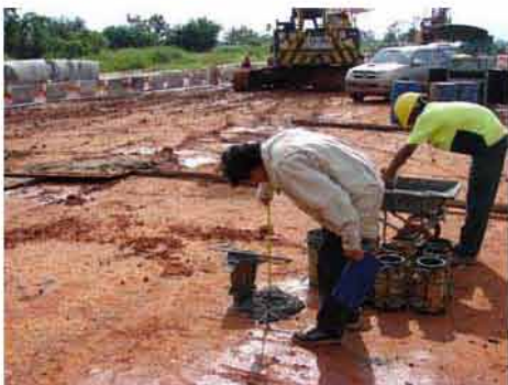
ควบคุมคุณภาพคอนกรีตก่อนเท
