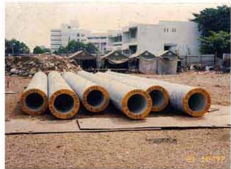
เสาเข็มคอนกรีตเสริมเหล็กหล่อสำเร็จอัดแรง
