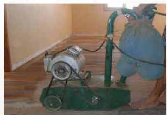
งานขัดพื้นไม้
