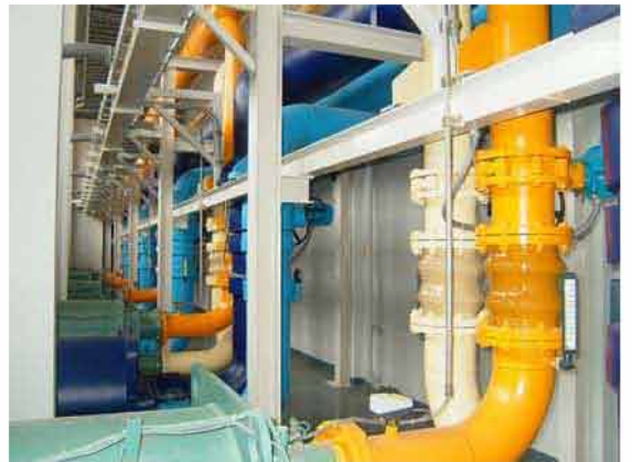
ติดตั้ง Water-Cooled Chiller
