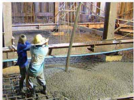
เทคอนกรีตพื้นชั้นใต้ดิน
