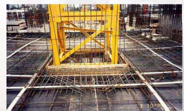
บริเวณช่องเปิดพื้นคอนกรีตอัดแรง
