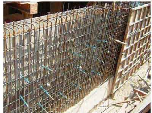
ประกอบแบบหล่อผนัง
