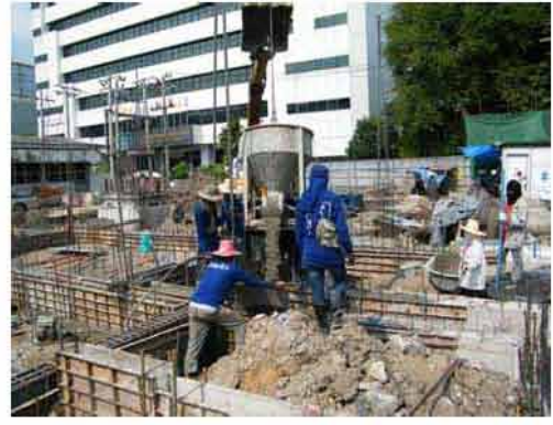
เทคอนกรีตคาน
