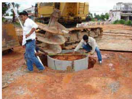
ตรวจสอบตำแหน่งหลักปักปลอกเหล็ก
