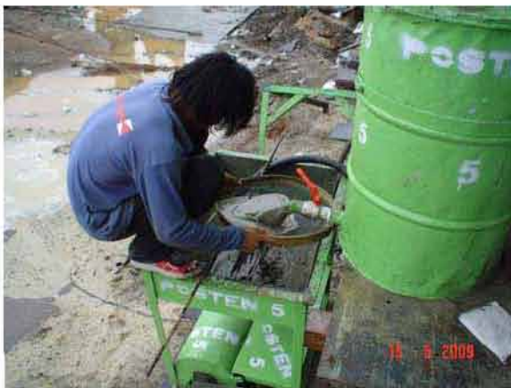
อัดน้ำปูนในท่อ Sheet
