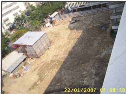
Clearing พื้นที่ และก่อสร้างสำนักงานชั่วคราว
