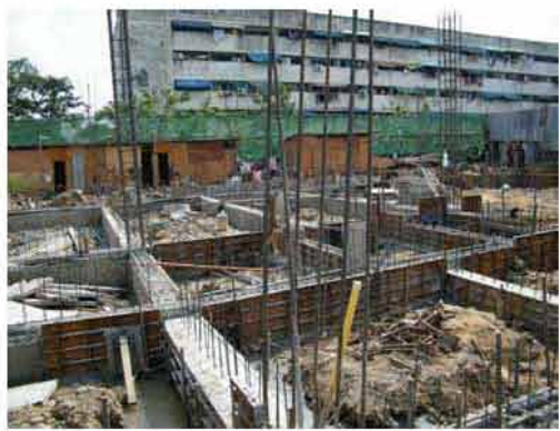
ถอดแบบหล่อคาน
