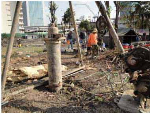
กดบล็อกเหล็กกันดิน
