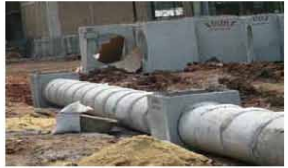
ท่อคอนกรีตเสริมเหล็ก
