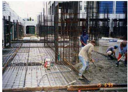
เทคอนกรีตทับหน้า
