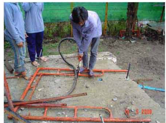
อัดน้ำปูนในท่อ Sheet
