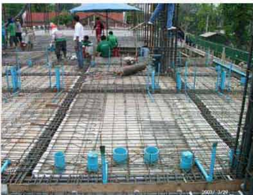
การวาง Sleeve บริเวณห้องน้ำ
