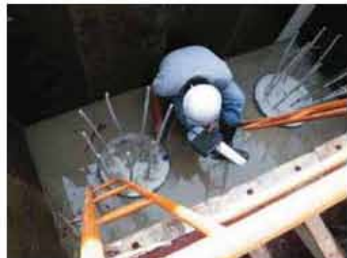
ตรวจสอบความสมบูรณ์ของเสาเข็ม
