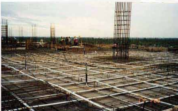
เตรียมเทพื้นคอนกรีตอัดแรง
