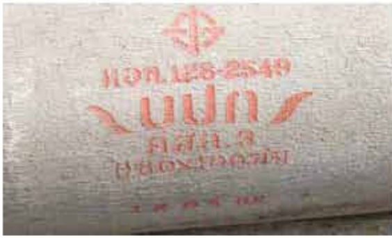
ท่อคอนกรีตเสริมเหล็ก
