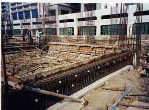
ผูกเหล็กเสริมคาน หนุนลูกปูน
