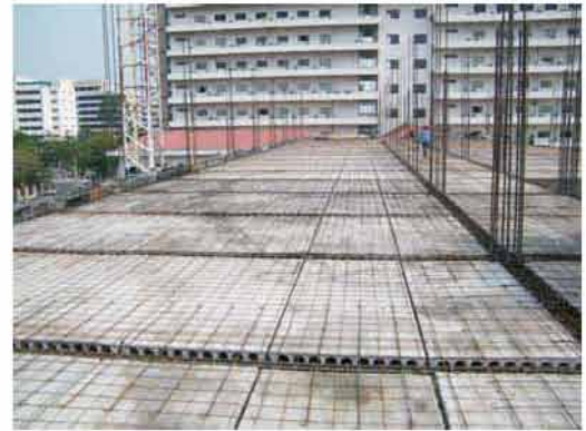
วางเหล็กเสริมเพื่อเทคอนกรีตทับหน้า
