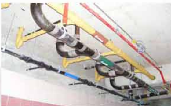
ท่อสุขาภิบาลใต้ห้องน้ำ
