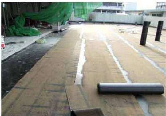
กันซึมแบบแผ่น membrane
