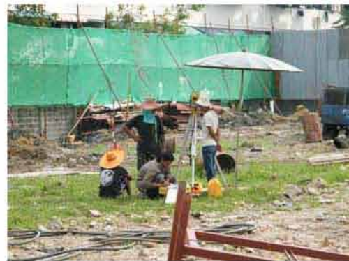
กำหนดตำแหน่งเสาเข็ม
