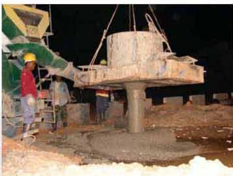
ควบคุมการเทคอนกรีตโดยใช้ท่อเทคอนกรีต
