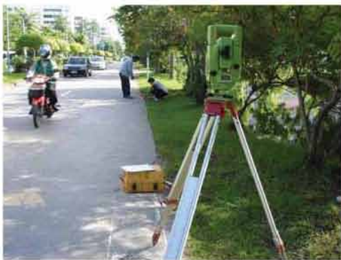
สำรวจพื้นที่ก่อสร้าง
