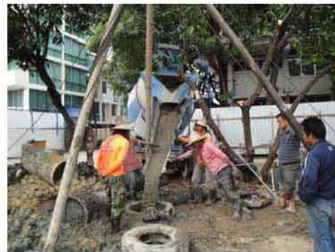
เทคอนกรีต
