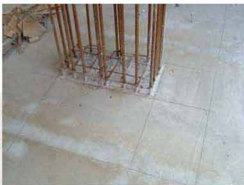
ตีแนวกรอบเสาและออฟเซต
