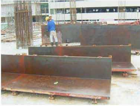
เตรียมแบบหล่อเสา
