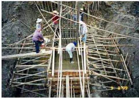
เทคอนกรีตฐานราก
