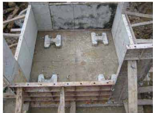
ติดตั้งแบบหล่อฐานราก
