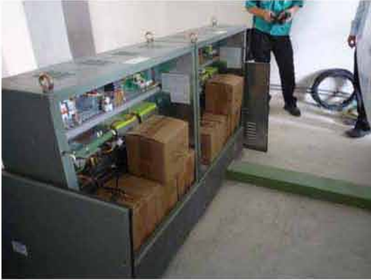
แบตเตอรี่ Back up
