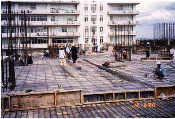
วางเหล็กเสริมล่าง
