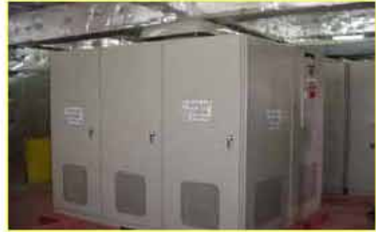
หม้อแปลง Dry Type และตู้ครอบ
