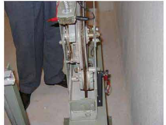
ตรวจสอบการทำงานของ Governor
