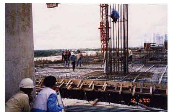
ตรวจสอบระดับแบบหล่อพื้นและเหล็ก
