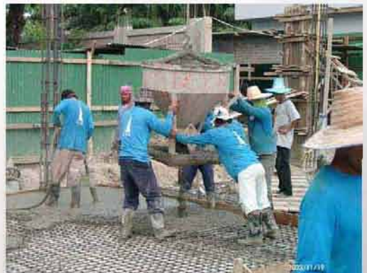
เทคอนกรีตพื้น
