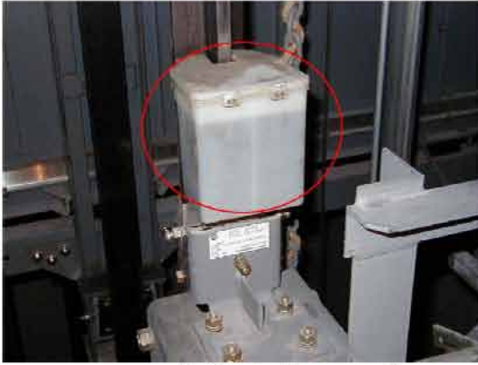
ตรวจสอบน้ำมันหล่อลื่นรางลิฟต์
