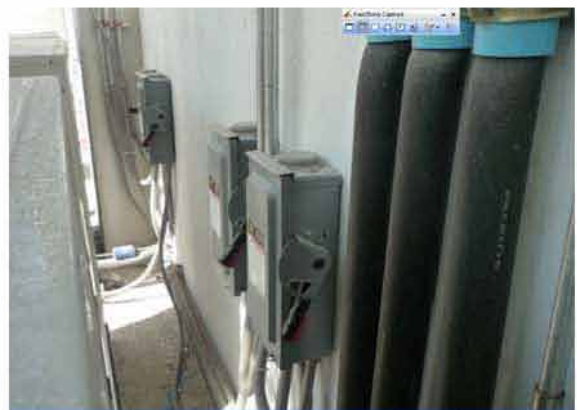
ติดตั้ง Safety Switch ทุกเครื่อง
