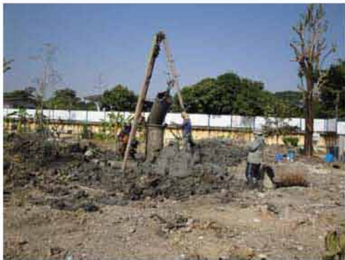
เจาะดินพร้อมต่อบล็อกเหล็ก
