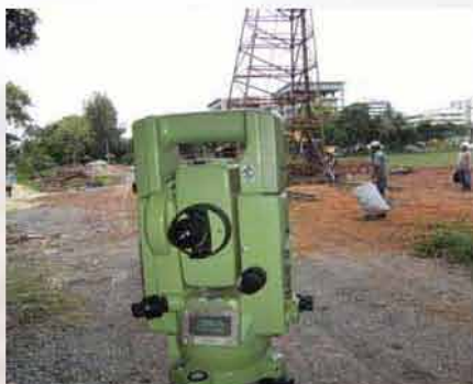
กำหนดตำแหน่งเสาเข็ม
