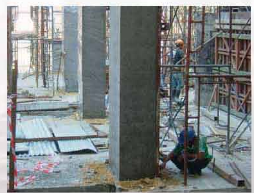
ถอดแบบหล่อเสาแล้วบ่มคอนกรีต
