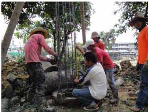
ลงเหล็กเสริมคอนกรีต
