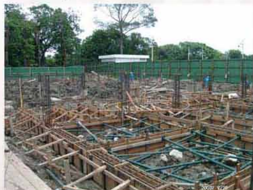
ประกอบแบบคานชั้นล่าง
