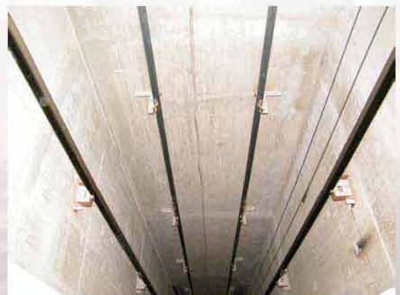
ติดตั้งรางลิฟต์
