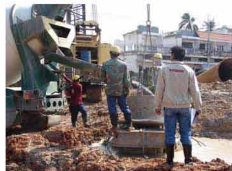
เทคอนกรีตและตรวจสอบปริมาณ
