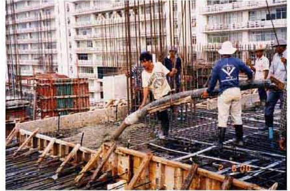
เทคอนกรีตพื้นคอนกรีตอัดแรง
