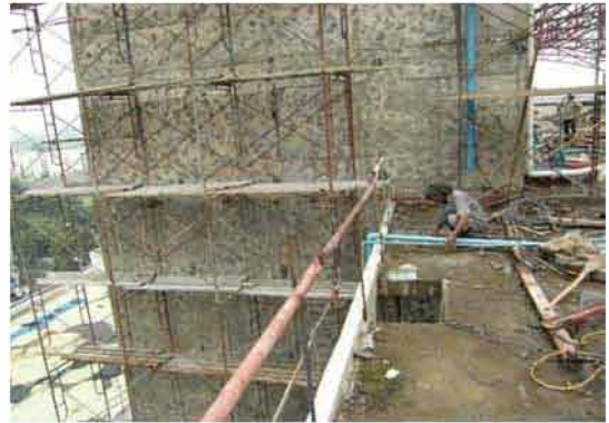
ผนังคอนกรีตเสริมเหล็ก
