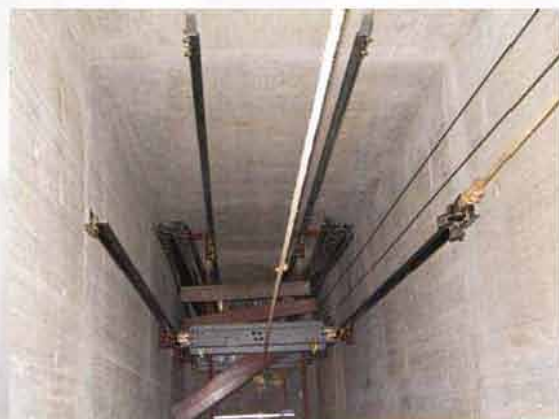
ติดตั้งรางลิฟต์
