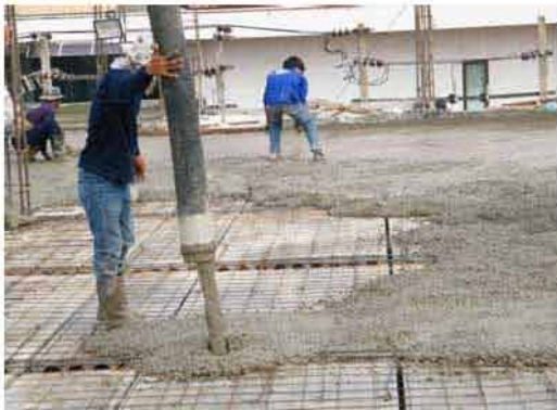
เทคอนกรีตทับหน้า
