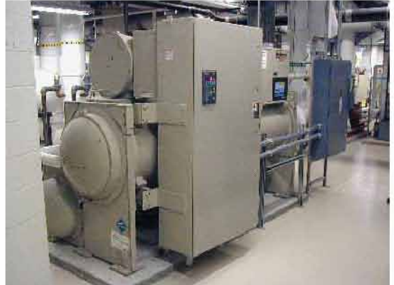
เครื่องทำน้ำเย็นแบบ Water-Cooled Centrifugal Chiller
