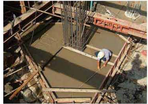
แต่งผิวหน้าคอนกรีตฐานราก
