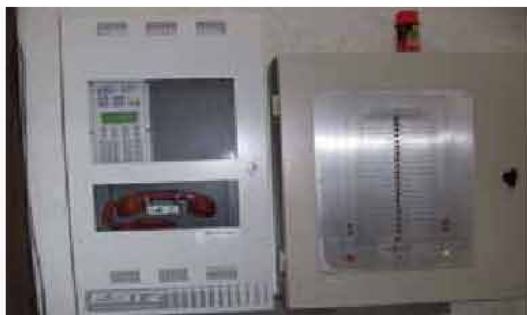
ตู้ควบคุมระบบสัญญาณและกราฟฟิค
