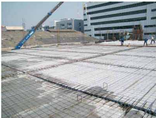
วางเหล็กเสริมเพื่อเทคอนกรีตทับหน้า
