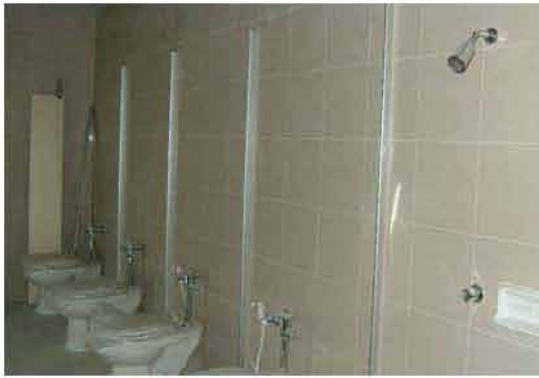
ติดตั้งโถส้วมและอุปกรณ์
