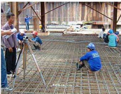
สำรวจระดับเหล็กเสริมพื้นชั้นใต้ดิน
