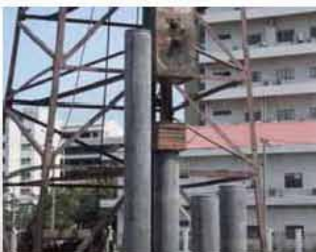
ทดสอบการรับน้ำหนักของเสาเข็มโดยวิธี พลศาสตร์ มยผ.๑๒๕๒
