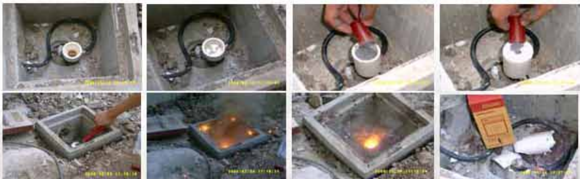
การต่อเชื่อมสายตัวนำลงดินโดยวิธี Exothermic Welding
