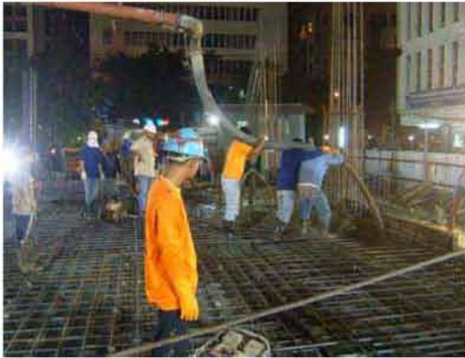
เทคอนกรีตพื้นไร้คาน
