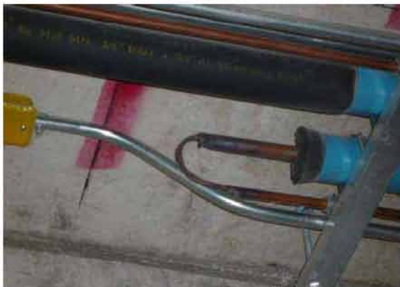
ทดสอบรอยรั่วท่อน้ำยา
