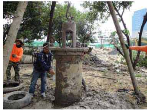
ตรวจสอบตั้งของบล็อกเหล็กกันดิน
