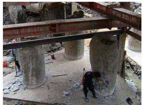
สกัดตัดเสาเข็ม
