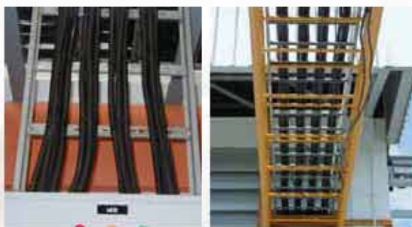
รางเคเบิล (Cable tray)
