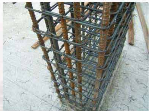
ผูกเหล็กเสริมเสา
