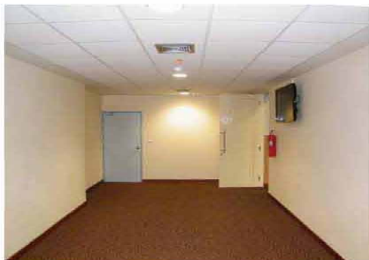
ฝ้ายิบซัมบอร์ดโครงคร่าวที่บาร์
