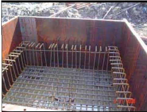
ลงเหล็กเสริมฐานราก
