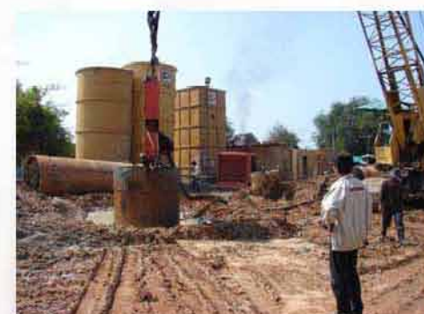
ถอนบล็อกเหล็กโดย Vibro Hammer
