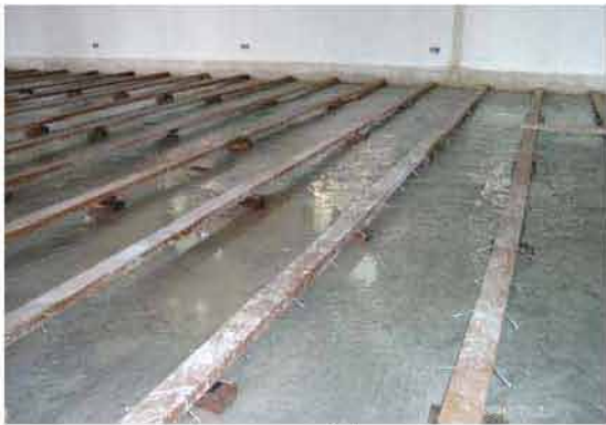
วางตงรับพื้นไม้
