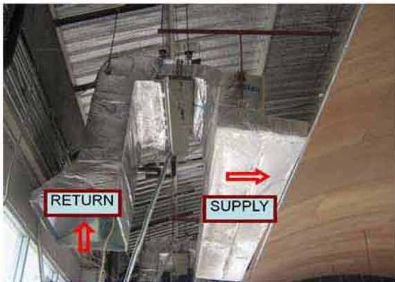
เครื่องปรับอากาศแบบซ่อนในฝ้า
