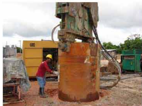
ตรวจสอบตั้งขณะปักปลอกเหล็ก
