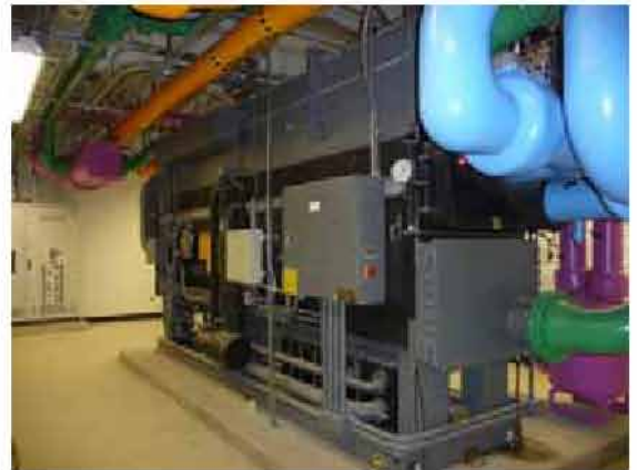
เครื่องทำน้ำเย็นแบบ Steam Driver Absorption Chiller
