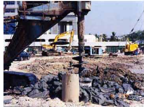
เจาะดินโดยใช้หัวแบบสว่าน และ แบบถังเจาะ
