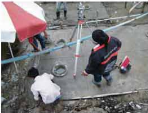
การตรวจสอบศูนย์ของเสาเข็ม
