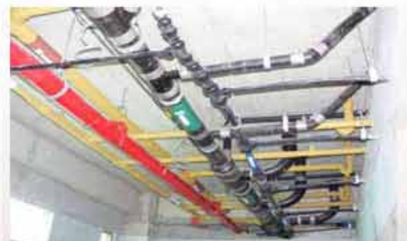
ท่อสุขาภิบาลใต้ห้องน้ำ
