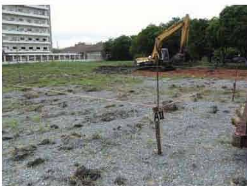
งาน Clearing ทำผังบริเวณ
