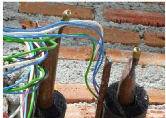
ใส่วาล์วเพื่อทดสอบรอยรั่วท่อน้ำยา
