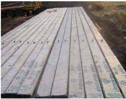
เสาเข็มคอนกรีตเสริมเหล็กอัดแรงหล่อสำเร็จ
