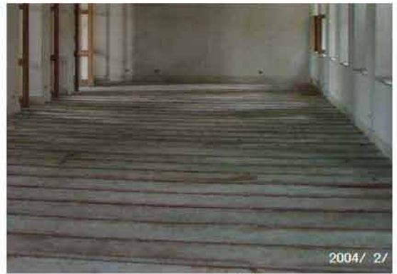
วางตงรับพื้นไม้
