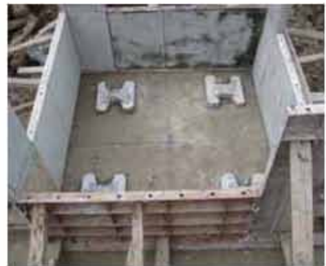
การตรวจสอบศูนย์ของเสาเข็ม
