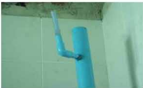
ทดสอบท่อน้ำทิ้ง น้ำโสโครก
