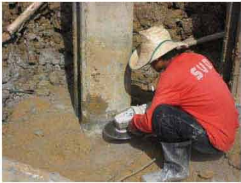
ตัดเสาเข็ม
