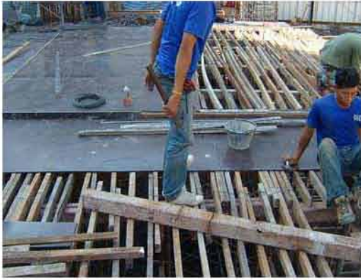
ตั้งนั่งร้าน ติดตั้งแบบหล่อพื้น
