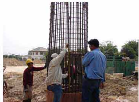
ลงเหล็กเสริมเสาเข็ม ควบคุมการต่อเหล็ก
