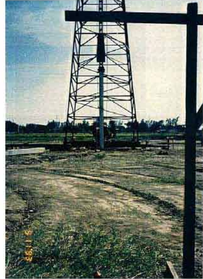
ควบคุมแนวตั้งของเสาเข็มและระยะยกตุ้ม
