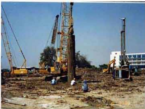
ควบคุมตั้งและตำแหน่งขณะปักปลอกเหล็ก
