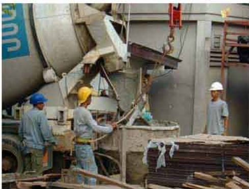
เทคอนกรีตเสา
