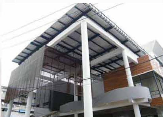
หลังคาเหล็กกรีดลอน
