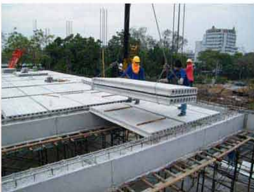
ยกแผ่นพื้นขึ้นติดตั้ง
