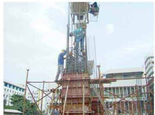
เทคอนกรีตเสา
